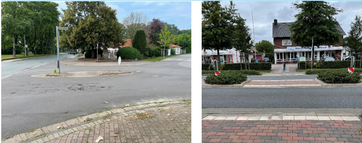
Abbildung 14: Schmale Querungshilfe am Habbrügger Weg (links) und Querungshilfe mit Regelbreite auf der Stedinger Straße (rechts)
