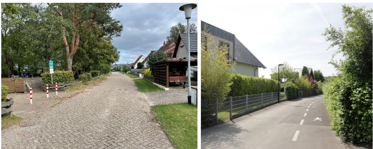
Abbildung 6: Vogelbeerstraße mit fehlenden Gehwegen (links) und Beispiel eines abmarkierten Gehbereichs (rechts)
