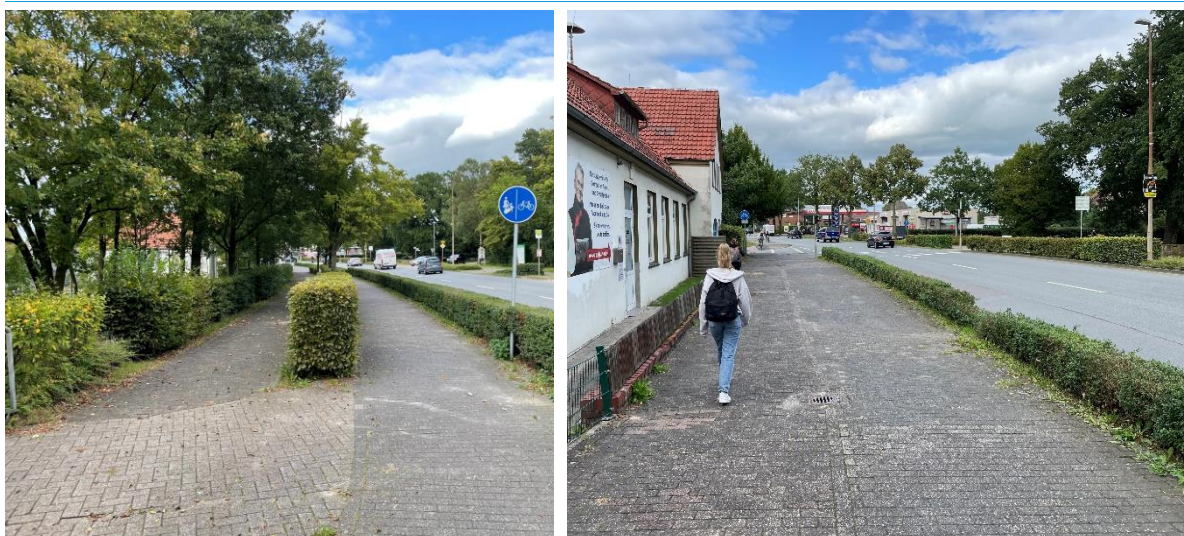
Abbildung 20: Getrennter Geh- und Radweg an der Stedinger Straße
