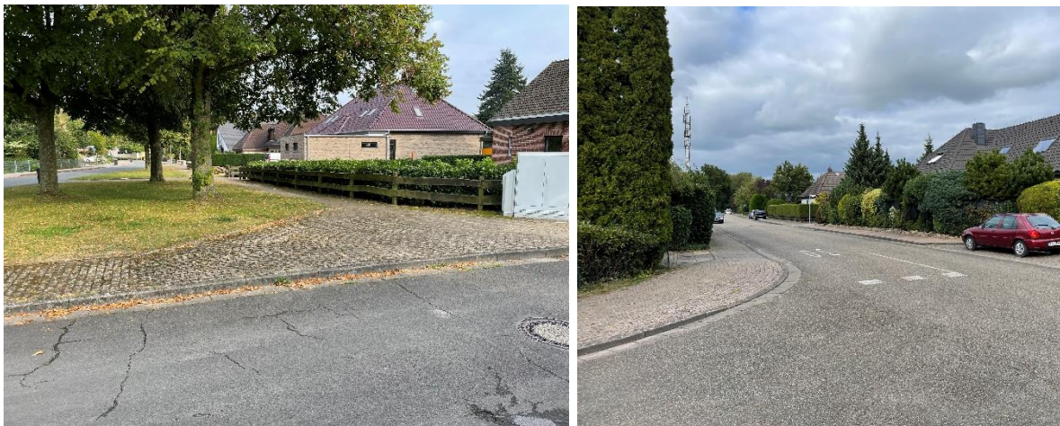
Abbildung 7: Fehlende Bordsteinabsenkung (links) und bereits abgesenkte Borde im Querungsbereich im Schäfersweg (rechts)
