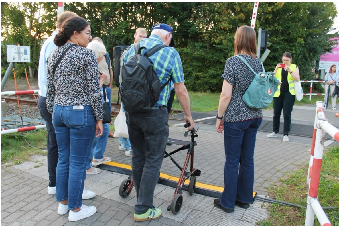
Abbildung 35: Bahnübergang mit Kabelbrücke als Hindernis für Mobilitätseingeschränkte
