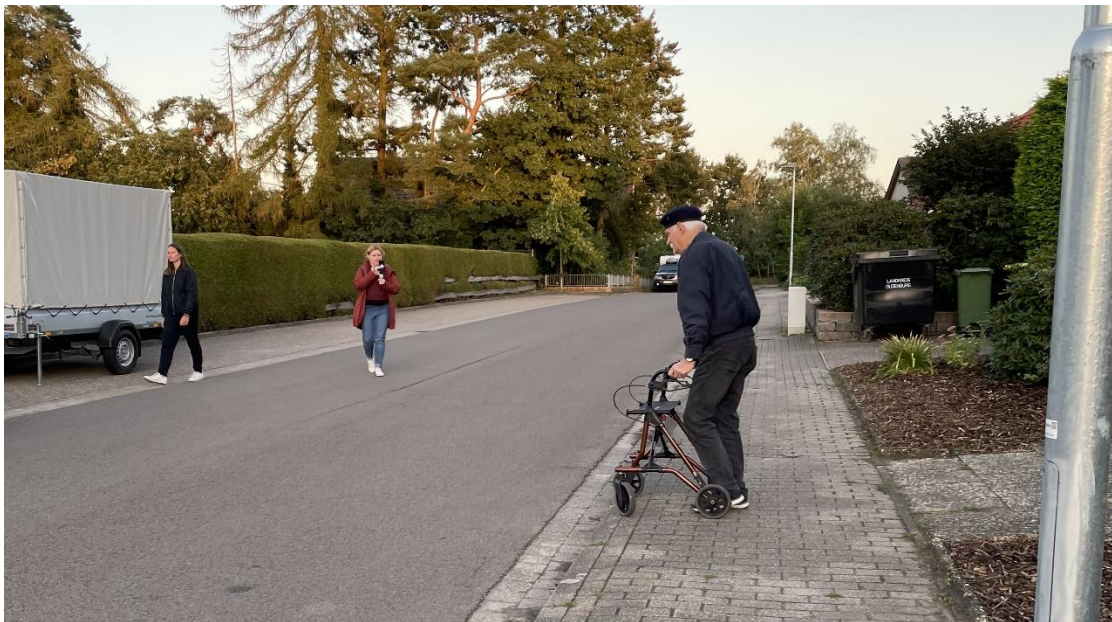
Abbildung 43: Fehlende Bordsteinabsenkungen im Friedensweg vor dem Friedhof
