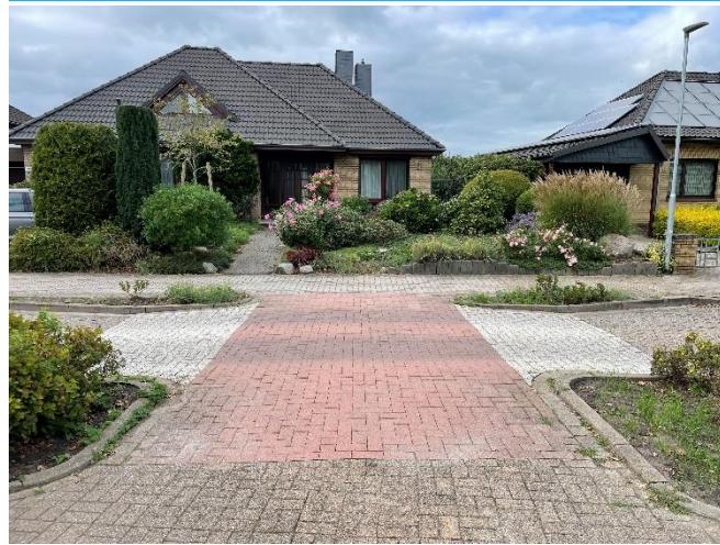
Abbildung 17: Teilaufpflasterung auf der Straße Übern Berg
