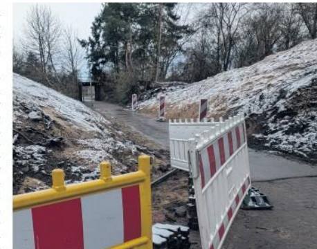
Ein Ergebnis des Fußverkehrs-Checks: Seit Ende Dezember ist die Eisenbahnanterführung in der Nähe der Lüchower Grundschule Geschichte. Foto: F. Wiechel-Kramüller
